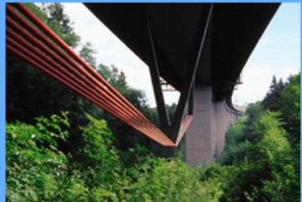
Bij deze moderne brug wordt de op duw geforceerde betonnen ligger onderspand met stalen kabels voor de trekkrachten.
