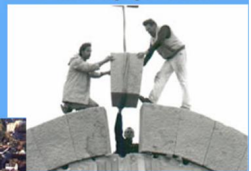
Een sluitsteen wordt geplaatst.
