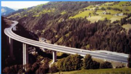
Vanwege de geringe kosten zijn snelwegbruggen vaak van beton, hier over de rivier Krems (Oostenrijk).
