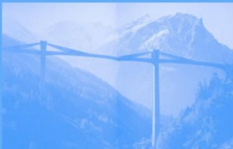
Het beton neemt bij de Ganterbrug (1980) in Zwitserland zowel druk als trekkrachten op.
