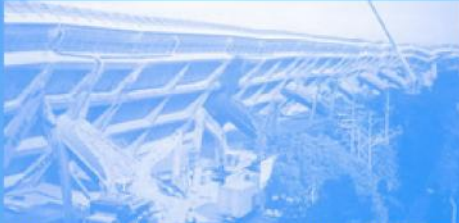
Na de aardbeving in Kobe (Japan) in 1995 viel de brug van de Hanshin snelweg om. In de gebarsten kolommen ziet men het stalen raster.
