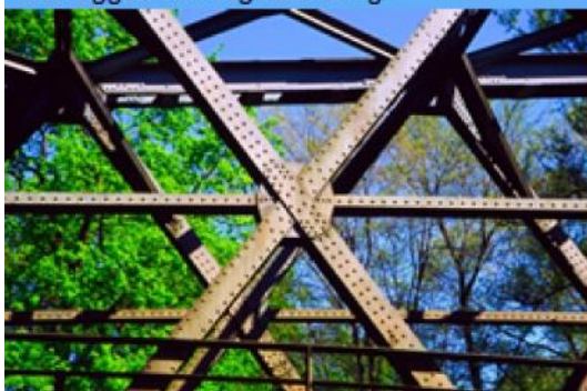
Het patroon van de popnagels in een stalen vakwerk.
